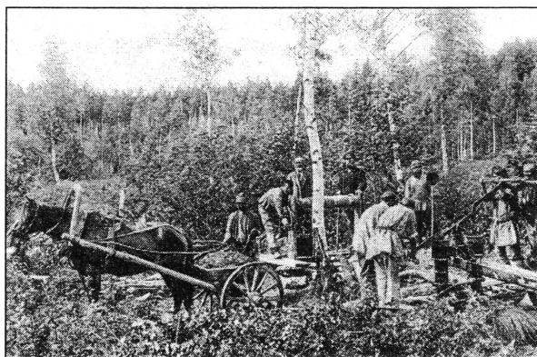
Промывка шурфа на платиновом приiske
